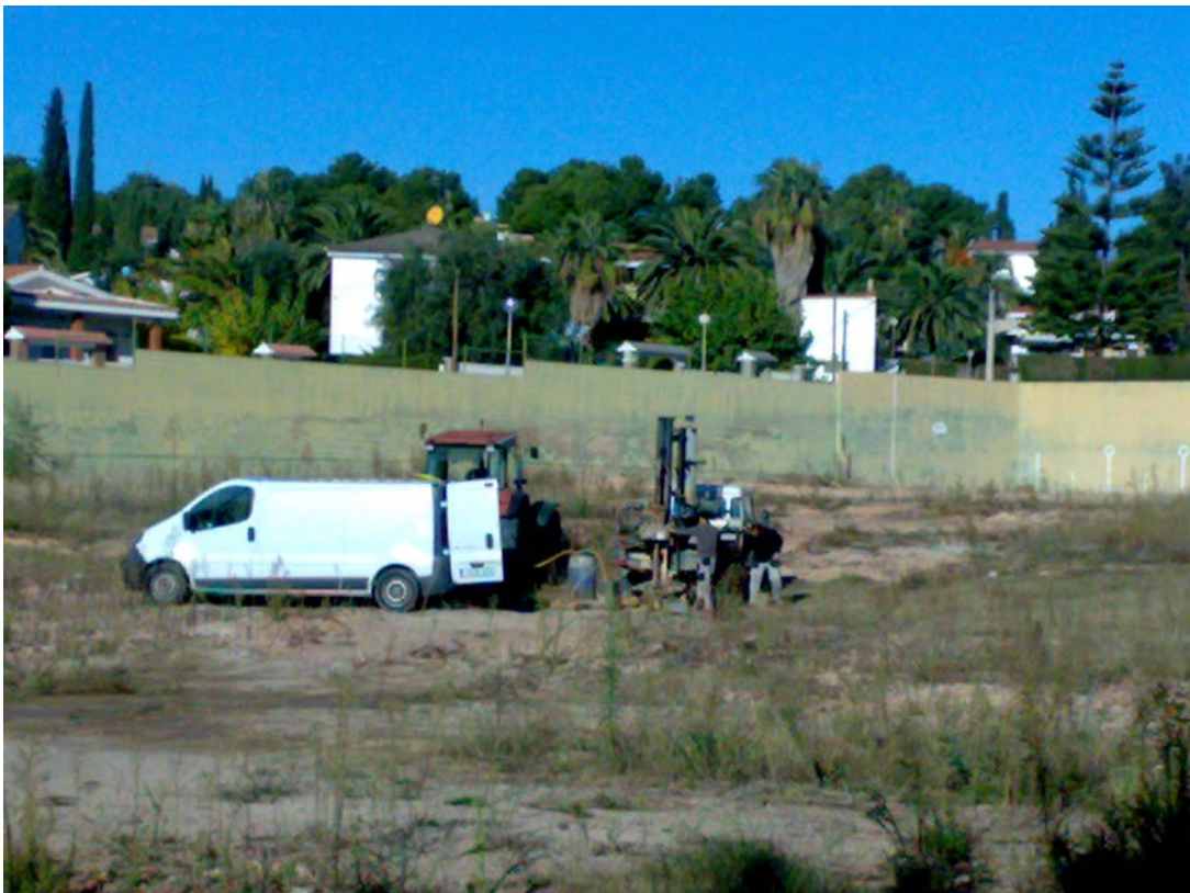
Fotografies 3 i 4. Assaigs Penetrosonda emplaçada en els sondeigs S1 i S5.
